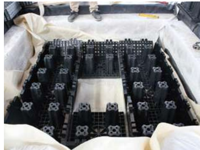
スーパージオ®SG300施工
