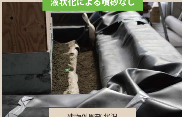
建物外周部 状況
