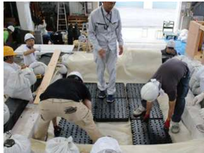
スーパージオ®SG70施工
