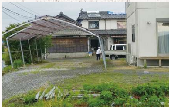
軽いカーポートが左に変位していることは地震の強さがうかがえます。
