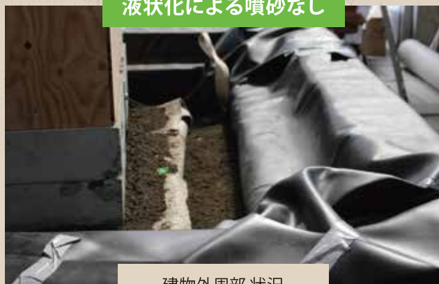
建物外周部 状況
